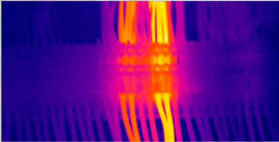
**Schaltschränke:** Überhitzte Elektrobauteile können zu einer erheblichen Gefahrenquelle werden und Brände auslösen.
